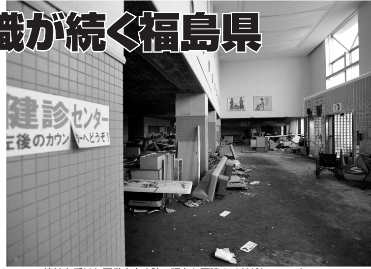
▲津波を受けた石巻市立病院。現在も再建のメドがたっていない
