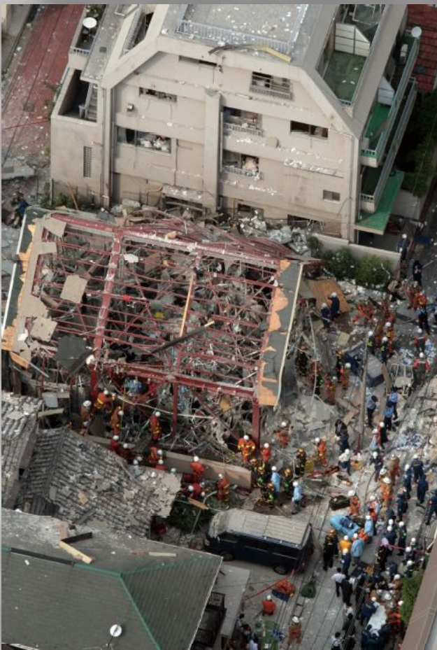
東京・渋谷の温泉施設倒壊 建物が全壊した事故現場
