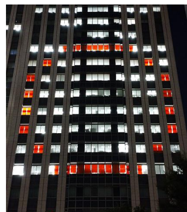
金融庁 (中央合同庁舎7号館)
